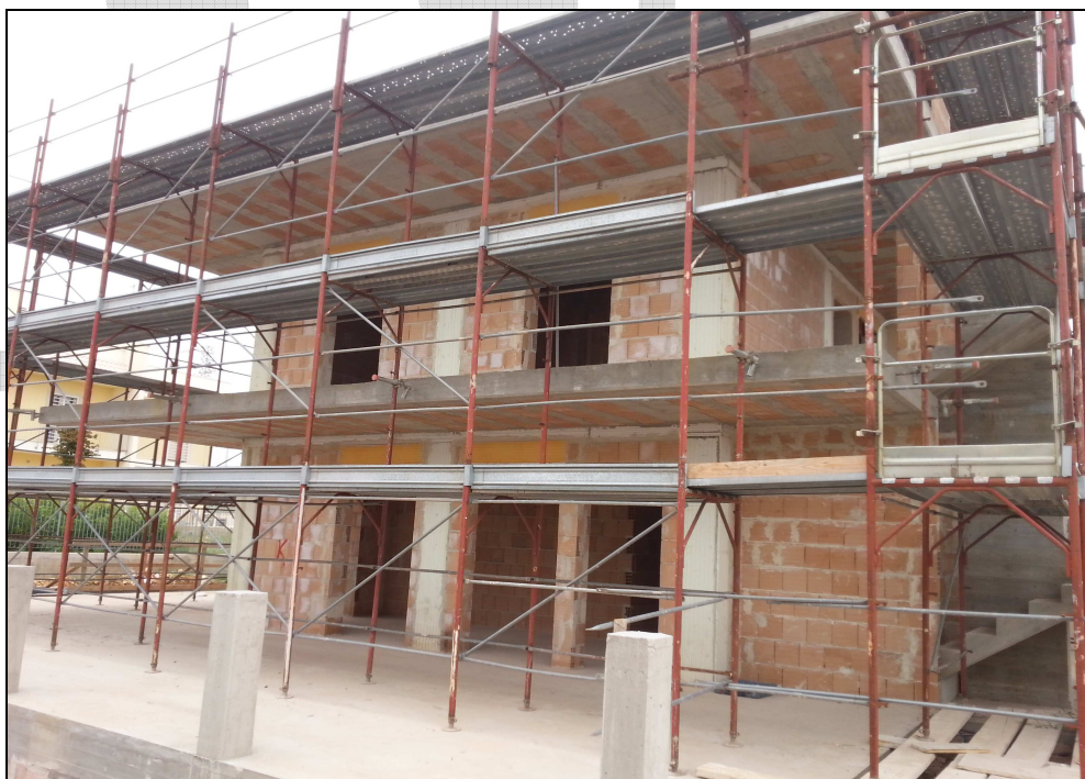
Particolare realizzazione murature di compagno. Nuova costruzione in Valenzano (BA)
