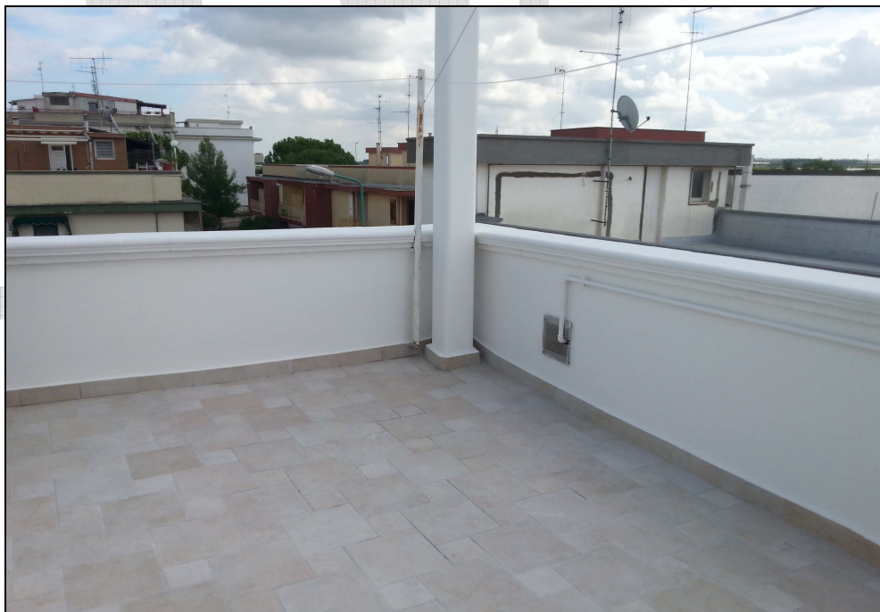
Particolare posa pavimento esterno "tre formati" finta pietra. Immobile ristrutturato in Adelfia (BA)
