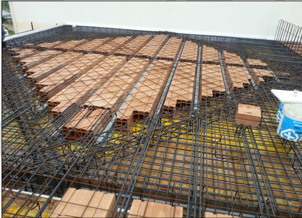
Particolare realizzazione solaio latero-cementizio a "cassa piena". Nuova costruzione in Valenzano (BA)
