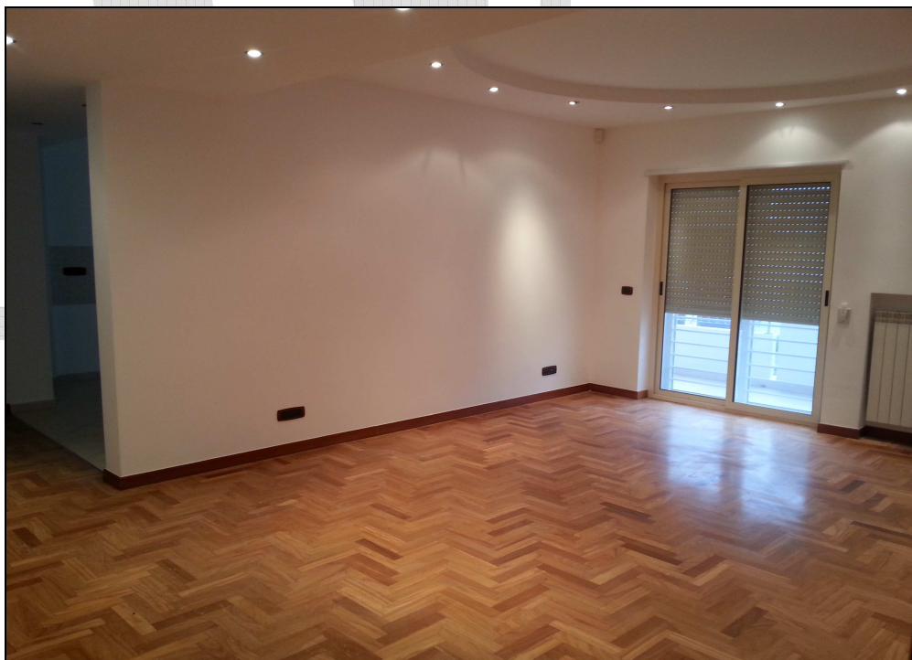
Particolare posa pavimenti e intonaci. Immobile ristrutturato in Adelfia (BA)
