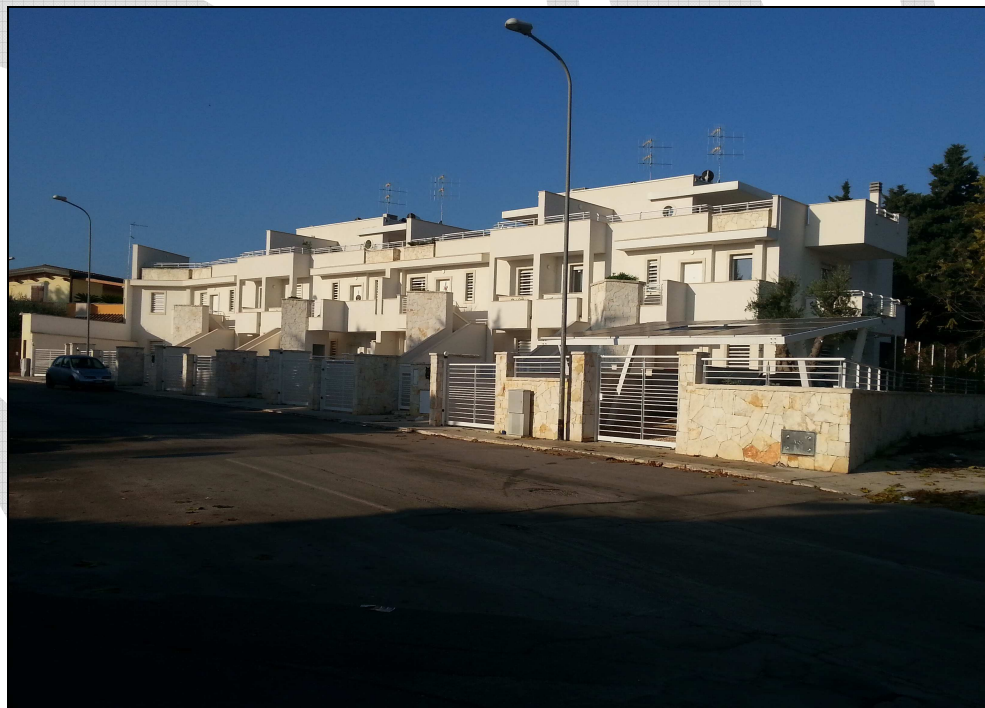
Costruzione di n. 8 villette a schiera - Nuova costruzione in Casamassima (BA).
