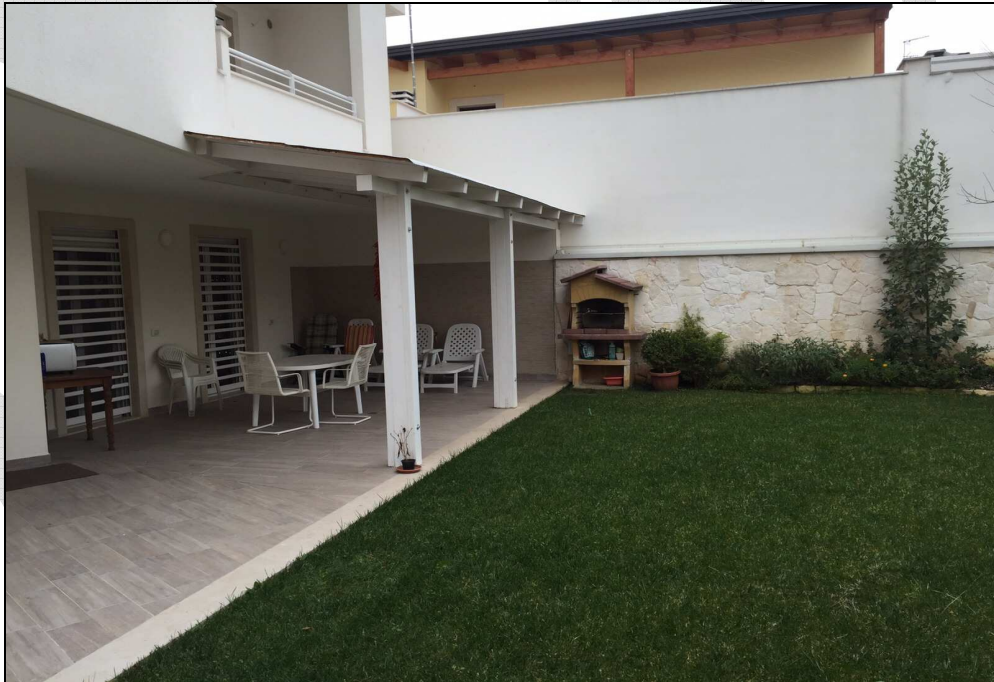
Particolare cortile di pertinenza esterna. Nuova costruzione in Casamassima (BA).
