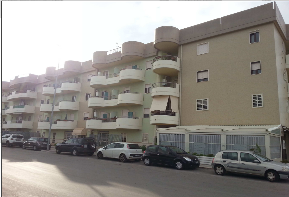
Nuova costruzione di n. 60 appartamenti in Valenzano (BA).
