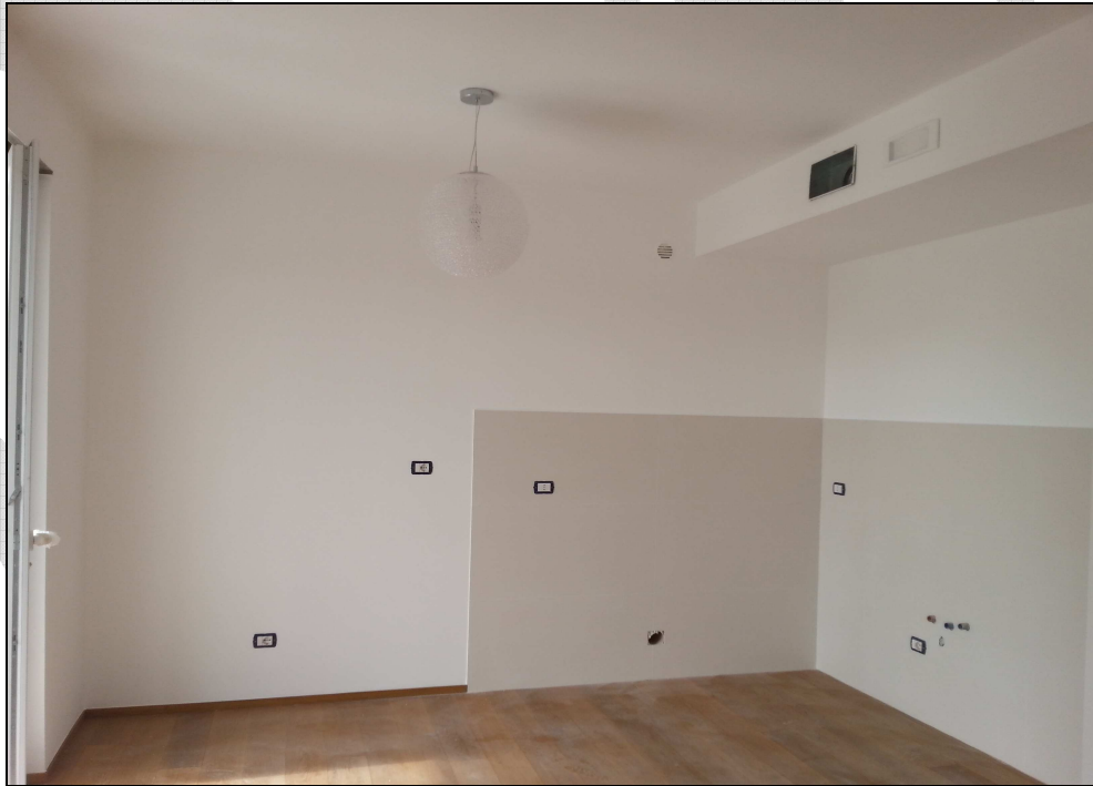
Rivestimento con lastre in Kerlite dim. 1,00x1,00 mt e sp. 3,5 mm. Immobile ristrutturato in Valenzano (BA)
