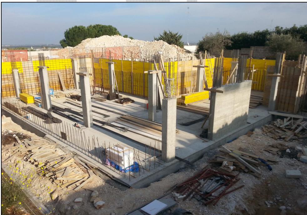
Particolare realizzazione carpenterie strutturali. Nuova costruzione in Cellamare (BA)
