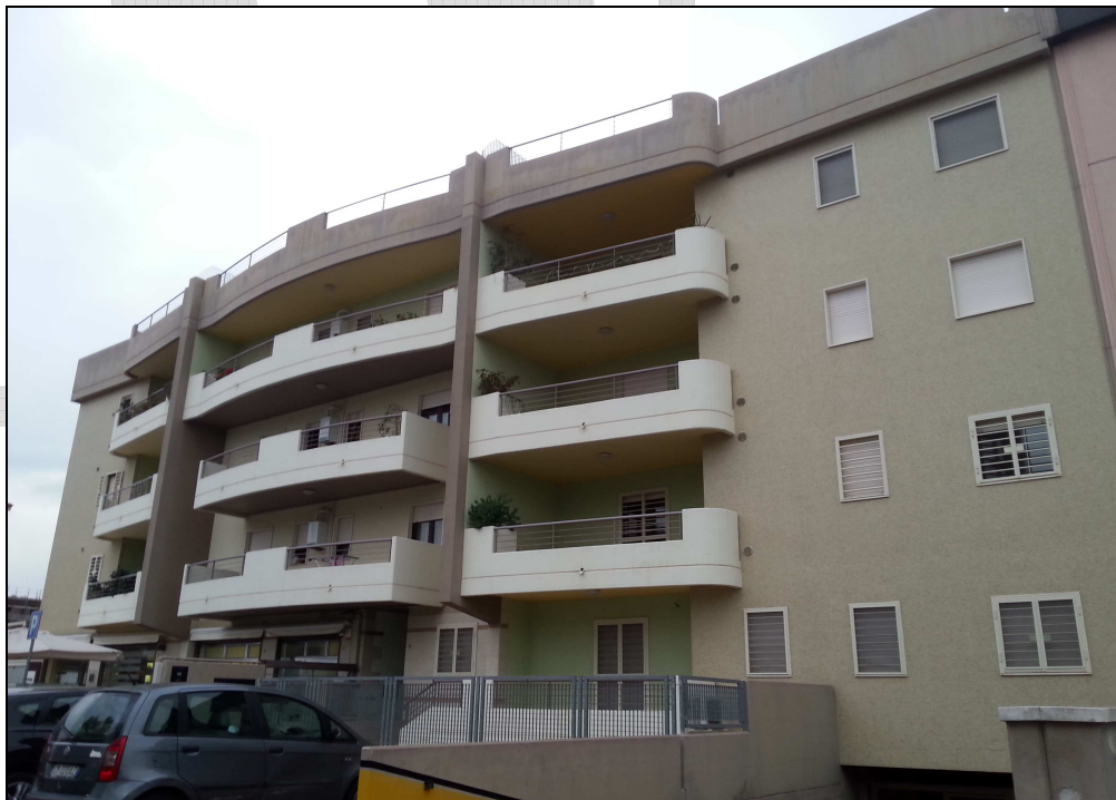
Nuova costruzione di n. 60 appartamenti in Valenzano (BA).
