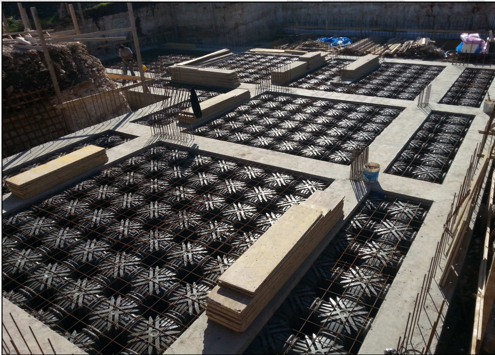
Particolare vespaio di aerazione con impiego iglù - Nuova costruzione in Cellamare (BA)
