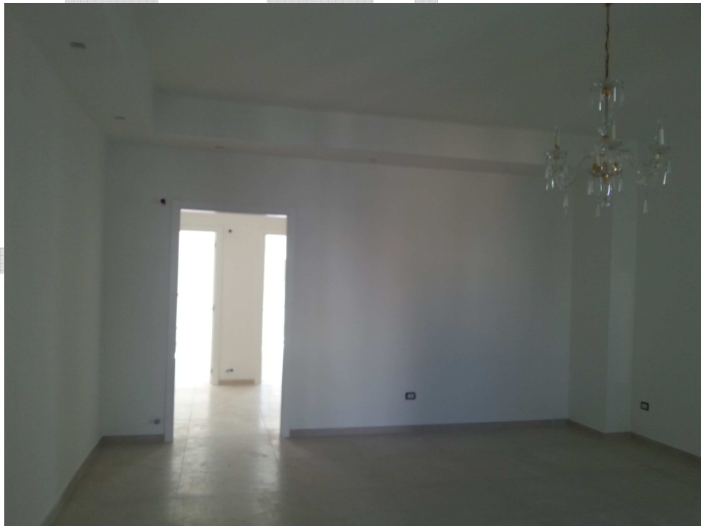
Particolare posa pavimento 90x90 cm ed intonacatura civile pareti. Immobile ristrutturato in Bari (BA)
