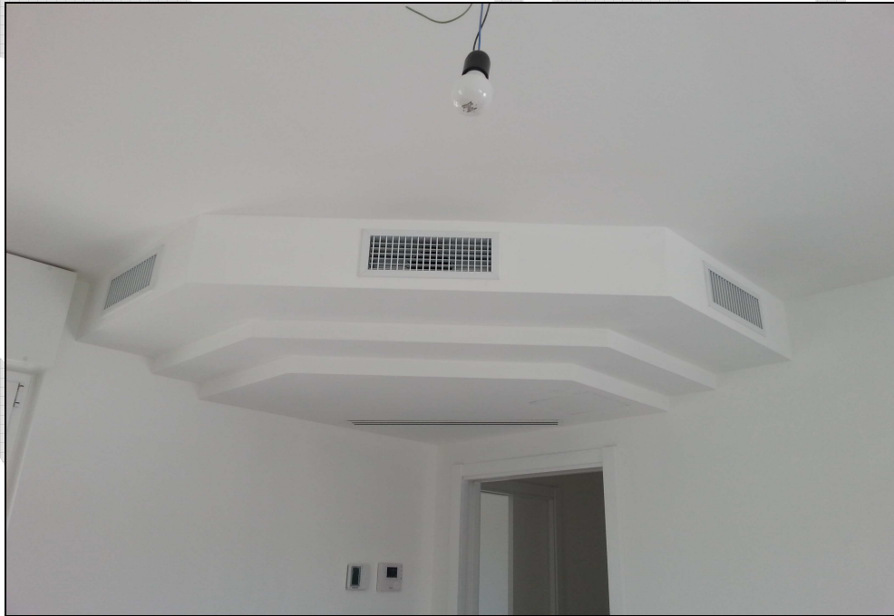
Particolare cassonetto sagomato in cartongesso. Immobile ristrutturato in Casamassima (BA)
