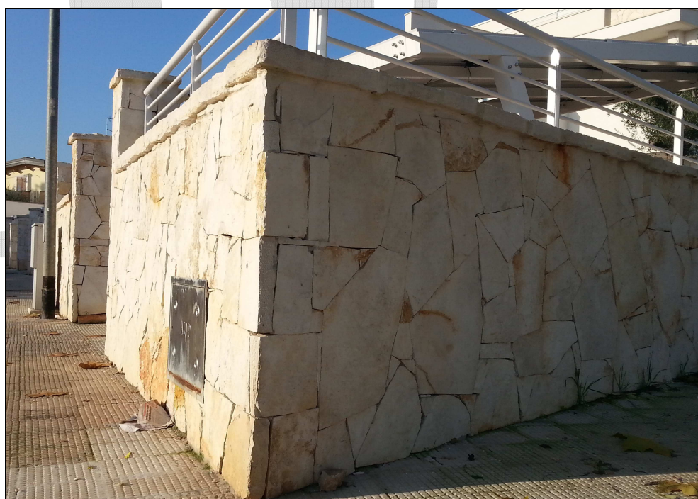
Particolare rivestimento in pietra viva. Nuova costruzione in Casamassima (BA).
